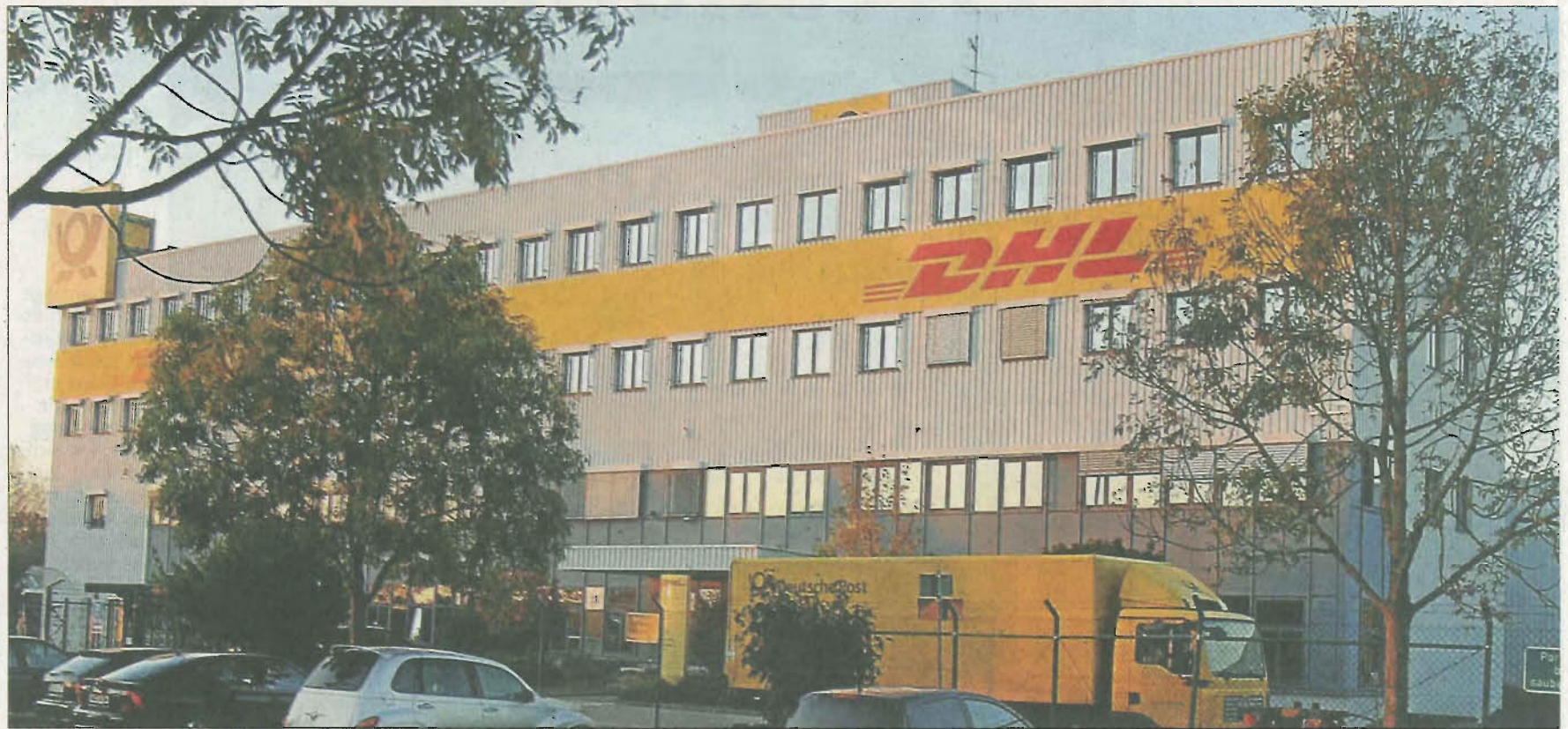
Hinter dieser Fassade auf dem Lahrer Flugplatz rauscht es gewaltig: Drei Kilometer Förderbänder und Rutschen sorgen dafür, dass Pakete von und nach Südbaden ihre Adressaten erreichen. Fotos: Merck
